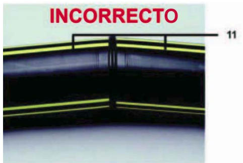
11. Tubería angulada hacia dentro de las unidades de fusión
